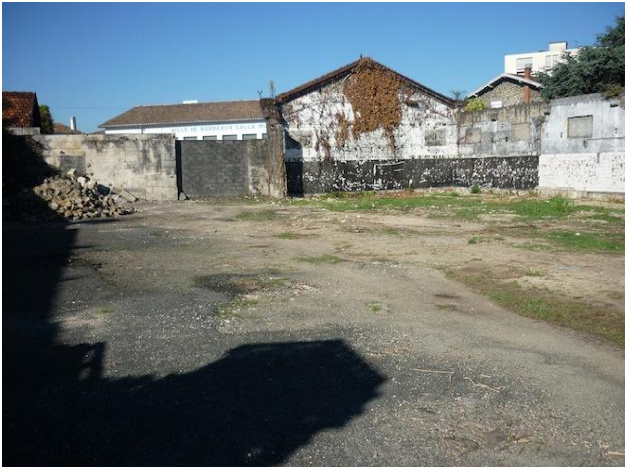
A l'origine, un terrain nu - Friche du groupe Bernard avant travaux janvier 2010
